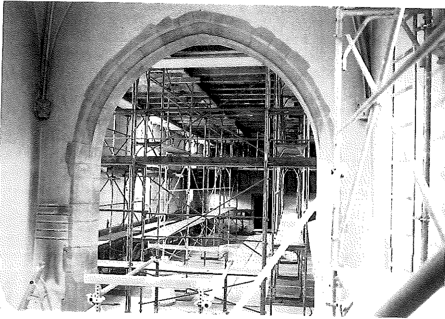
Blick vom Chor in die eingerüstete Kirche
