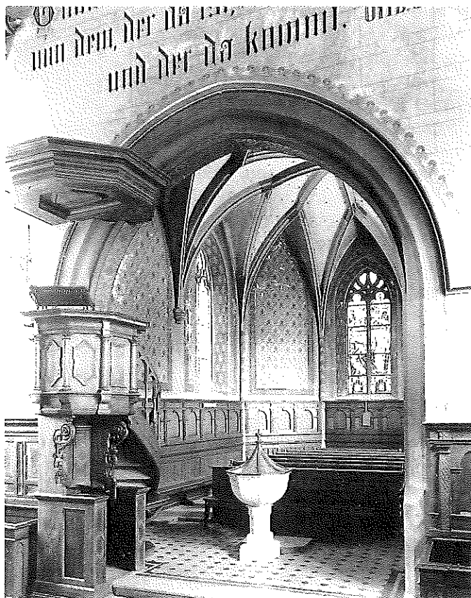
Chor mit Kanzel über dem Pfarrstuhl und Taufstein von 1896, Wände mit aufdringlicher Bemalung, vor dem Umbau von 1948
