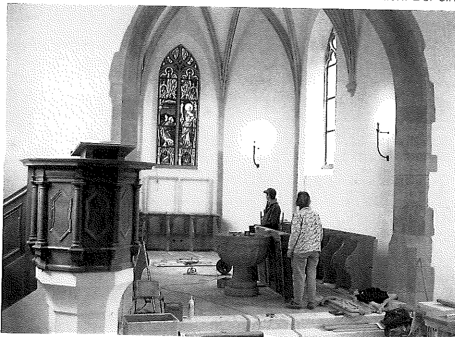
Einbau des Chorgestühls
